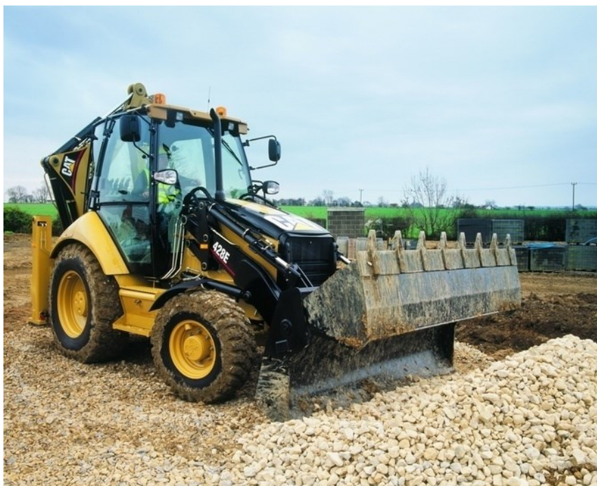
Obr. 4.8 Práce stroje Caterpillar 428E s víceúčelovou lopatou
