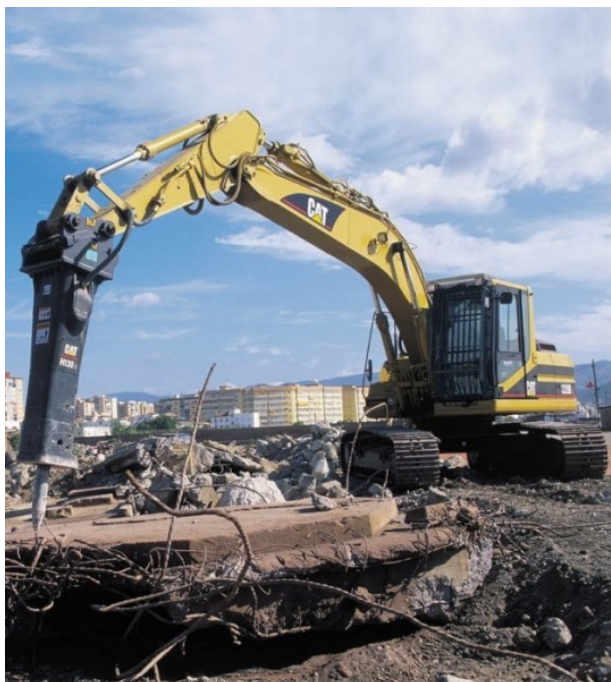
Obr. 4.30 Pásové rypadlo s hydraulickým kladivem – Caterpillar H130
