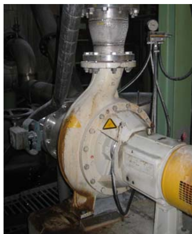
Obr. 3.19. Jednostupňové odstředivé čerpadlo
