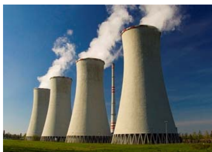
Obr. 5.34. Elektrárna Dětmarovice. Chladicí věže
