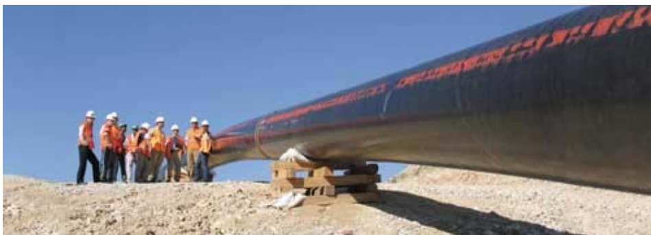
Obr. 3.12. Ropovod Baku – Ceyhan Průměr 1100 mm.. Maximální tlak 4 MPa. .
