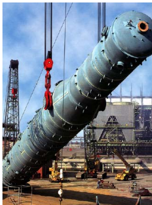
Stavba absorpční kolony pro 645 000 m 3 /h plynu, průměr 5,4 m, výška 62 m (Sasol, Jihoafr. Rep.)
