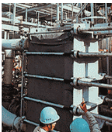
Obr. 4.11. Deskový výměník pro chlazení kyseliny sírové
