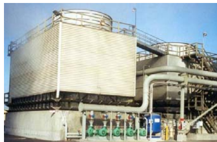
Obr. 5.33. Energeticky náročnější avšak prostorově menší chladiče mají v kratších komínech umístěny vrtulové ventilátory.
