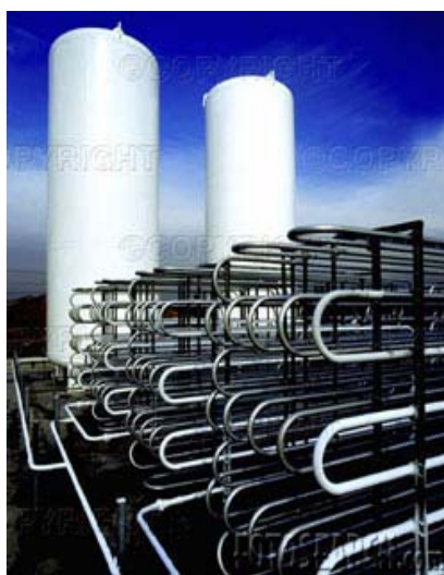
Obr. 4.7. Výměníky pro nízkoteplotní procesy – ohřev volnou konvekci vzduchu kolem trubek
